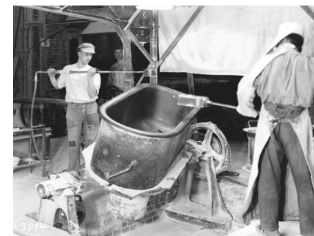
Badewannenproduktion in Lauchhammer um 1927 Bathtub production in Lauchhammer about 1927
